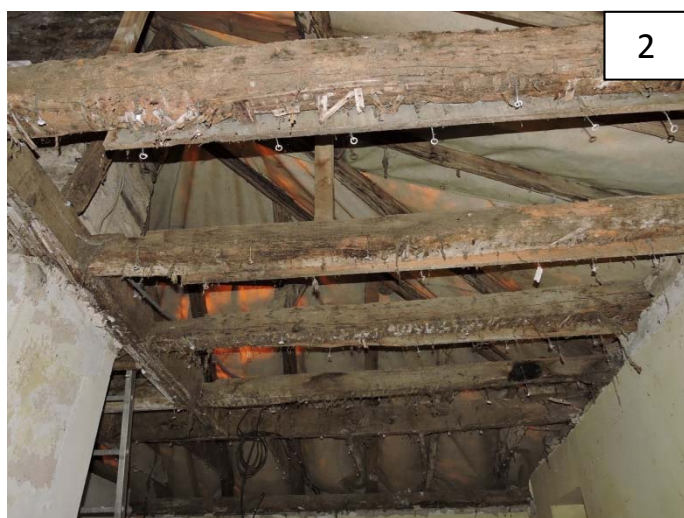
Photo 1 : Couverture avec double couche de volige en peuplier.
