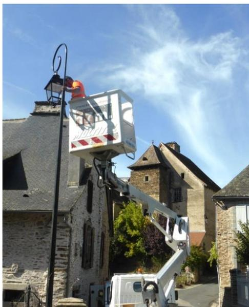
Cet éclairage à LED est allumé de 20 h à minuit (50 watts, densité à 100 %), A partir de minuit jusqu'au lever du jour (5 watts, densité à 10 %).
