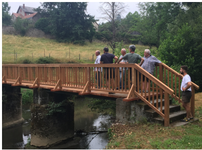
Réfection du Pont Richard
